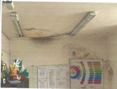
FORRO DE GESSO COM INFILTRAÇÃO
